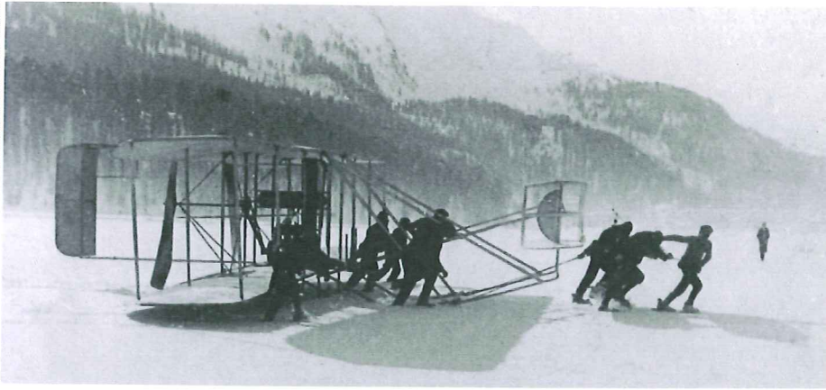
Paul Engelhards Wright-Doppeldecker wurde mit vereinten Kräften auf den St. Moritzer See gezogen. Der Kurverein unterstützte die Pionierflüge mit allen Mitteln.
